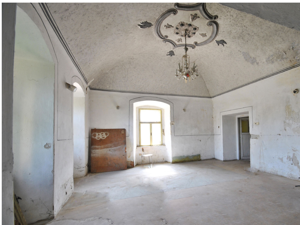
Severovýchodná miestnosť pôvodného krídla
