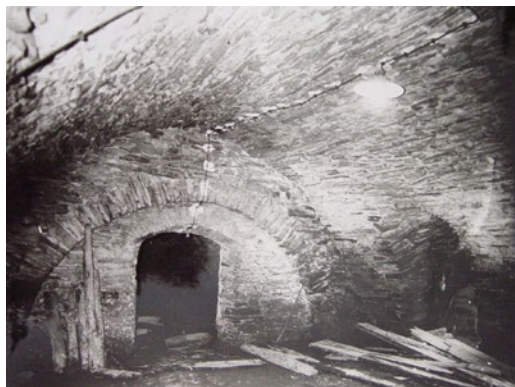
Pohľad do južného traktu suterénu s neomietnutým kamenným murivom a zaklenutím, v strede sekundárne podmurovaný klenbový pás, zdroj: Archív KPU PO, Pamiatkový výskum – Norma Urbanová 1978.
