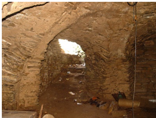
Pohľad do zaklenutého podzemného priestoru neznámeho objektu (asi kaplnky) v blízkosti kaštieľa, autorka foto: M. Janovská (rok 2019).
