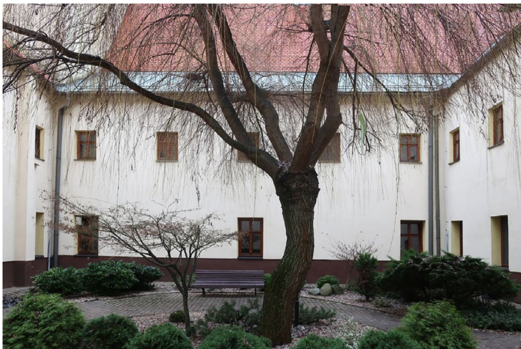
Obr. 12 Južná a časť východnej a západnej fasády južnej časti kvadratury a južná časť rajskeho dvora – aktuálny stav (pohľad zo severu).
