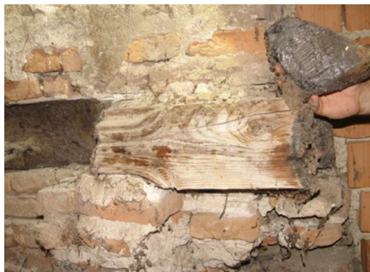
Detaily sekundárne zamurovaného profilovaného dreveného trámu v komínovom telese v podstreší, pochádzajúceho pravdepodobne zo starších odstránených drevených stropov, ktoré nahradili klasicistické klenby, autorka foto: M. Janovská (rok 2019).
