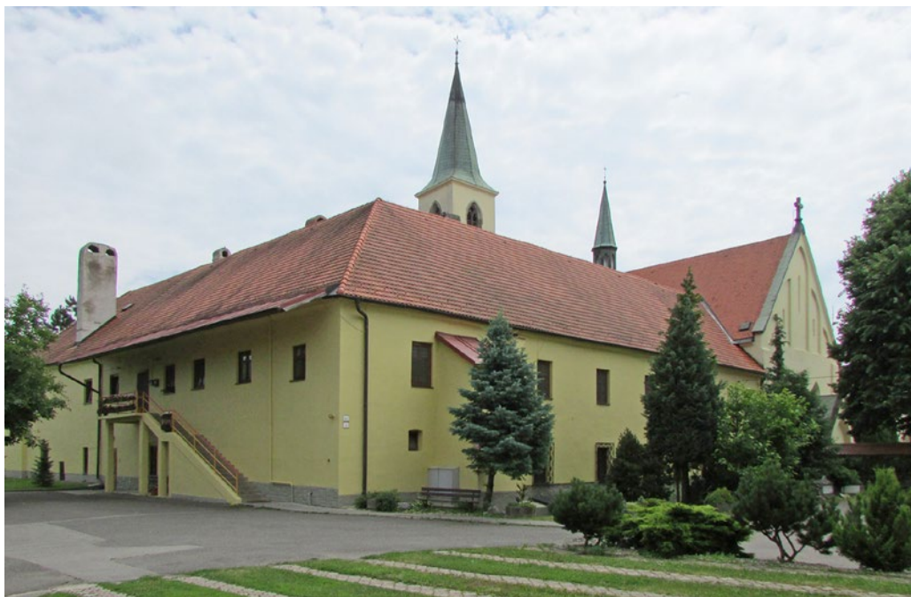
Obr. 11 Budova bývalého františkánskeho kláštora v Humennom – aktuálny stav (pohľad zo severozápadu).
