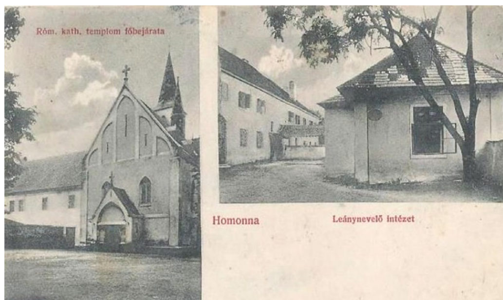
Obr. 9 Budova bývalého františkánskeho kláštora v Humennom na pohľadnici zo začiatku 20. stor. Zdroj: https://gallery.hungaricana.hu/
