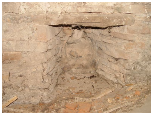
Zamurovaný štrbinový otvor (kľúčová strieľňa) v podstreší juhozápadnej nárožnej veže, autorka foto: M. Janovská (rok 2019).
