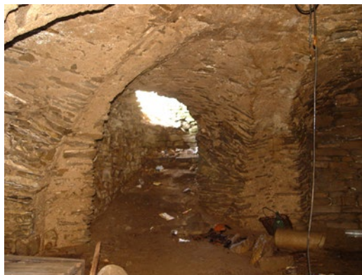
Pohľad do zaklenutého podzemného priestoru neznámeho objektu (asi kaplnky) v blízkosti kaštieľa, autorka foto: M. Janovská (rok 2019).
