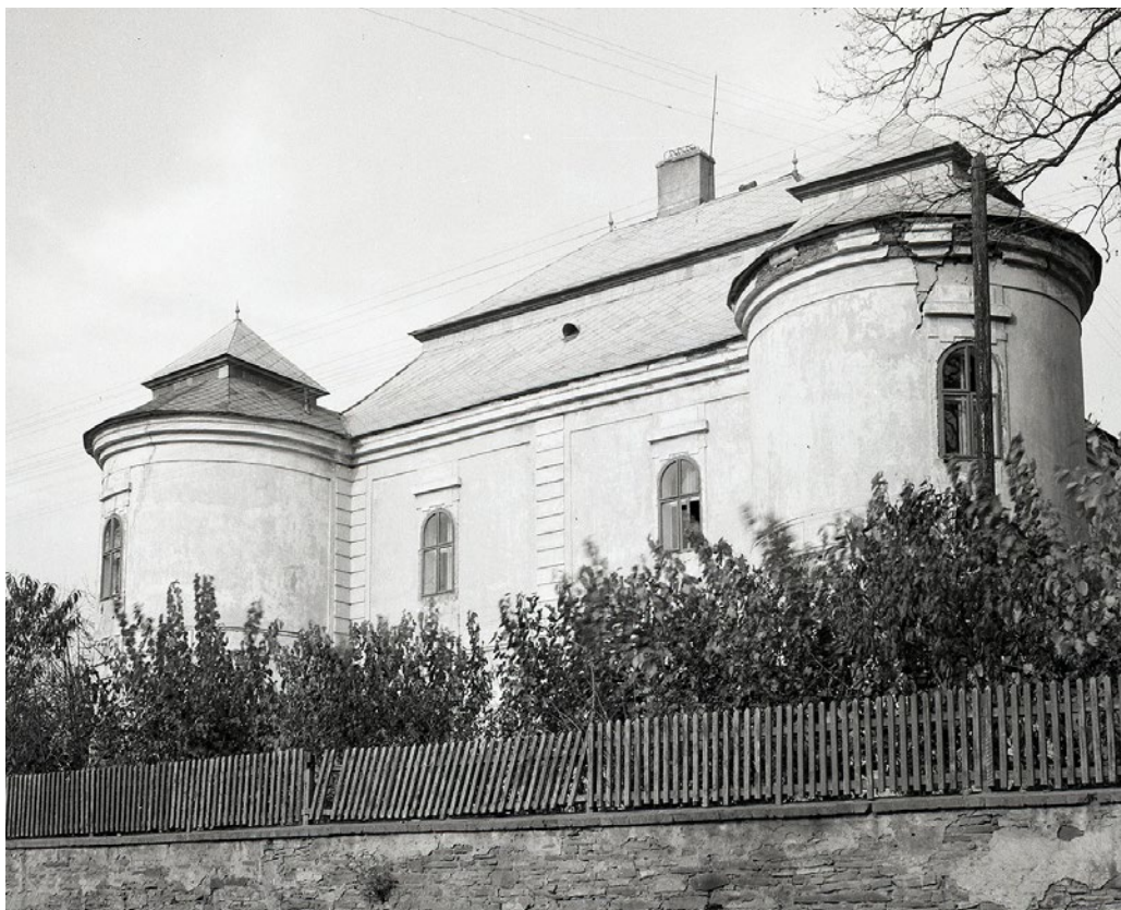
Stav kaštieľa v roku 1963 s úpravou fasády z prelomu 19. a 20. storočia, zdroj: Archív KPÚ PO, č. neg. 4991.
