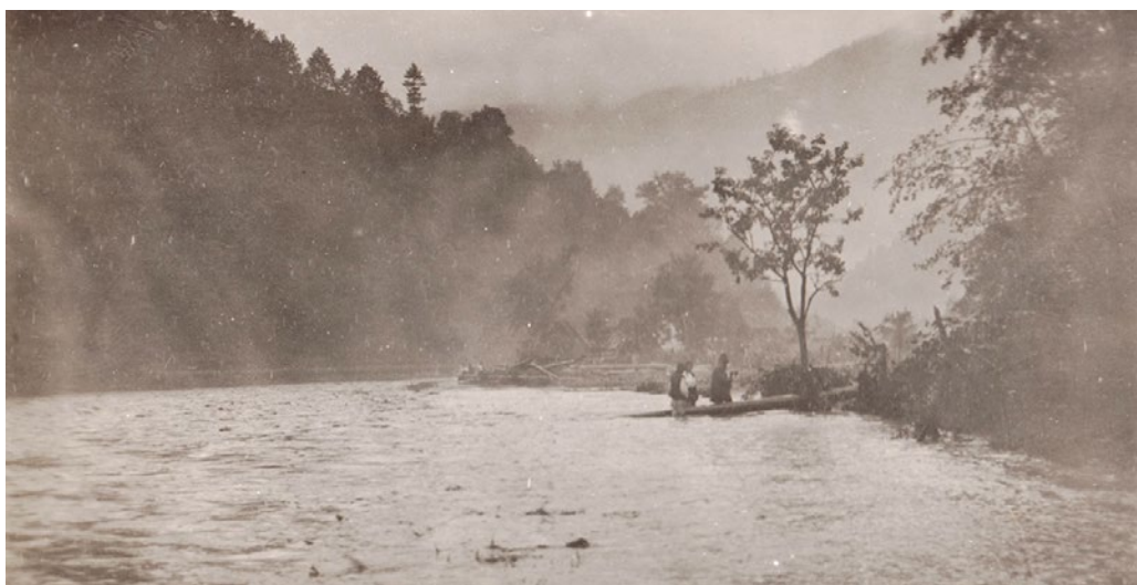
Obr. 10: Vodou překrytá silnice Rachov – Berlebaš. VÚA – VHA, f. DOV Chust, nezpracovaný spisový materiál o povodni z roku 1927.
