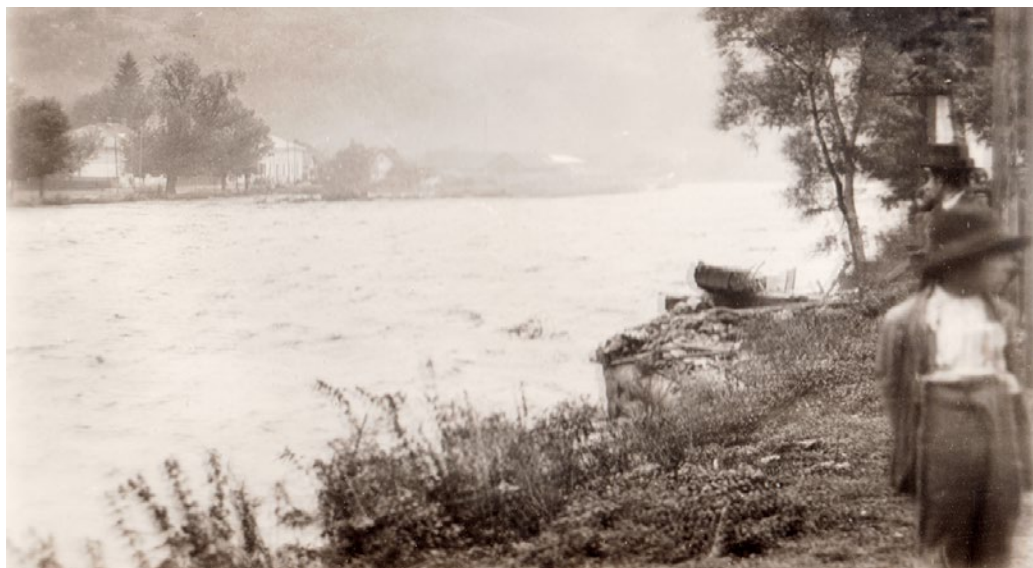
Obr. 7: Zbytky mostu v Rachově. VÚA – VHA, f. DOV Chust, nezpracovaný spisový materiál o povodni z roku 1927.
