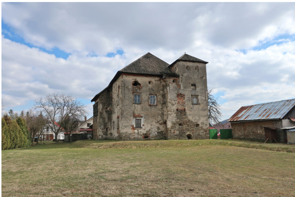
Kaštieľ v Pečovskej Novej Vsi (foto T. Haviar)
