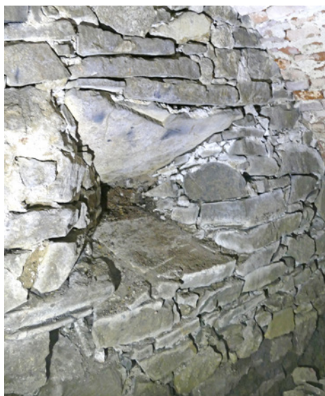
Kaštieľ v Uzovciach, zamurovaný otvor, zrejme strieľňa v suteréne (foto T. Haviar)
