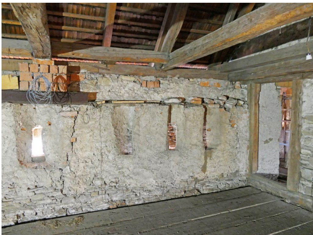
Kaštieľ v Pečovskej Novej Vsi, strielne v podstreší (foto T. Haviar)
