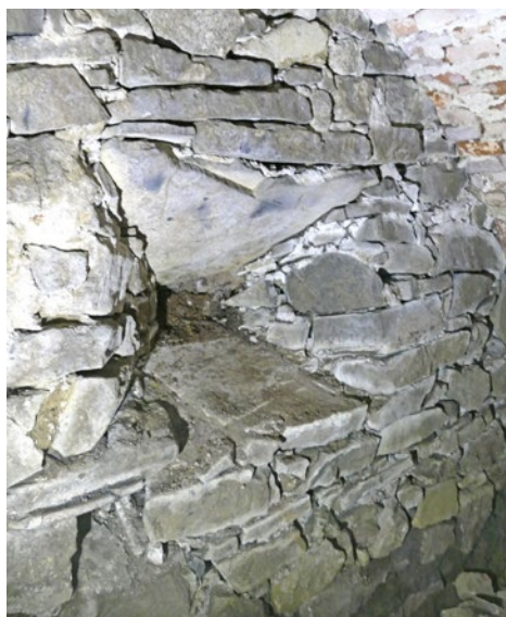
Kaštieľ v Uzovciach, zamurovaný otvor, zrejme strielňa v suteréne (foto T. Haviar)
