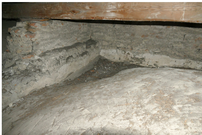
Podkrovie nad miestnosťou s bohatou štukovou výzdobou, viditeľná staršia omietka, ktorá patrila pôvodnému rovnému stropu miestnosti. Foto: T. Haviar
