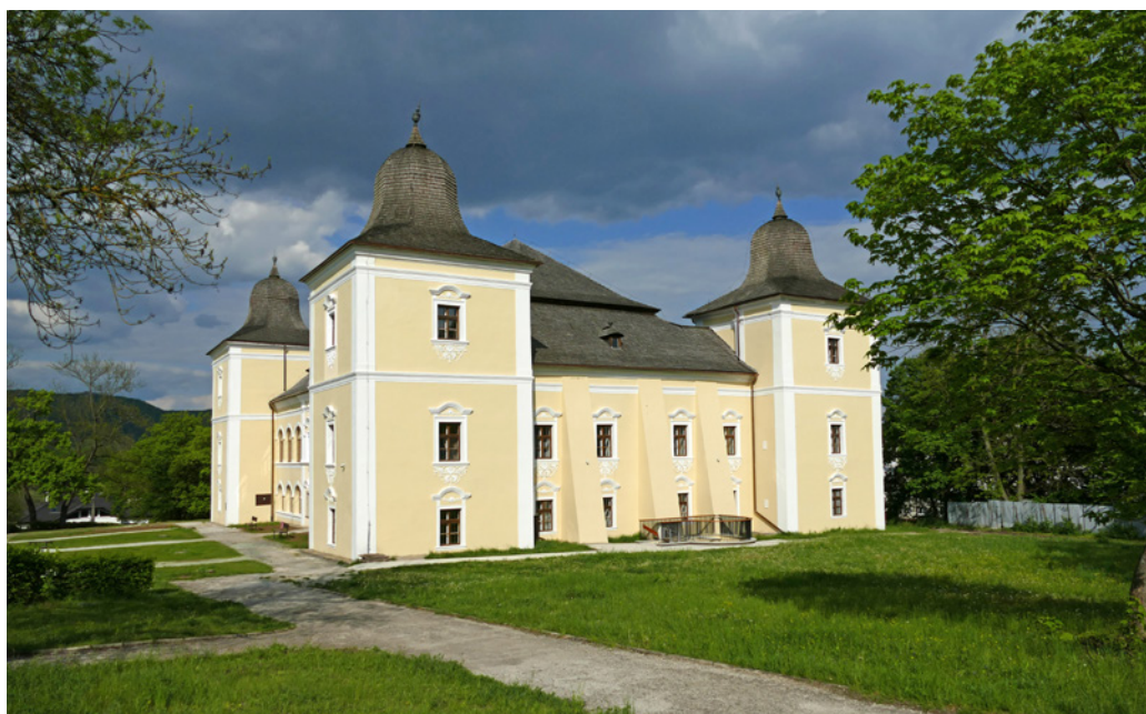
Juhozápadná fasáda s mladšími opornými piliermi. Foto: T. Haviar
