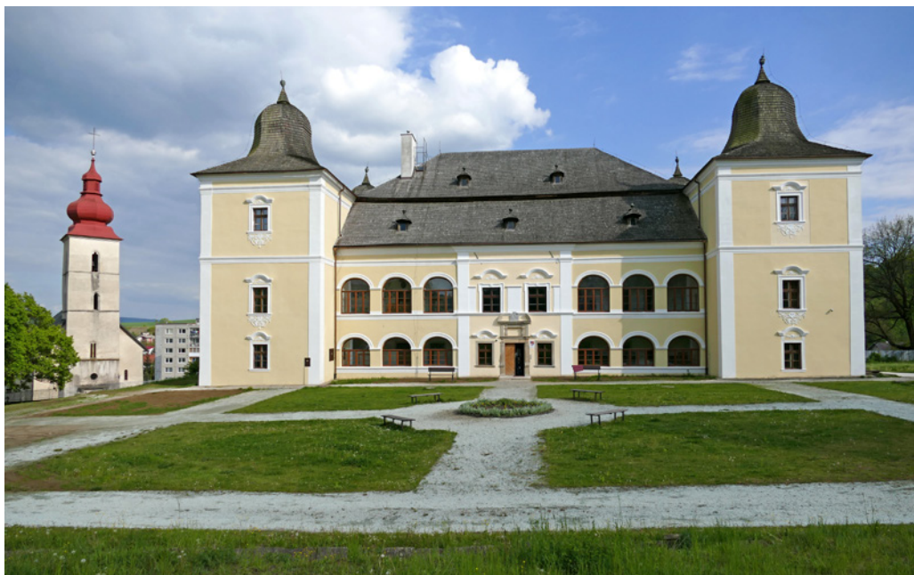
Hlavná fasáda kaštieľa s pôvodne božohrobským kostolom. Foto: T. Haviar
