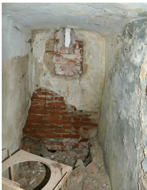
Odkrytý priestor toalety na prízemí južnej veže počas obnovy interiéru. Foto: T. Haviar
