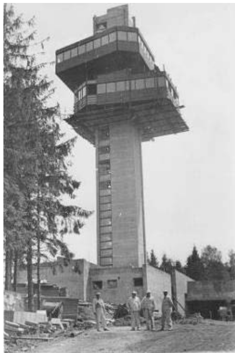
Súčasná vyhliadková veža pred dokončením
