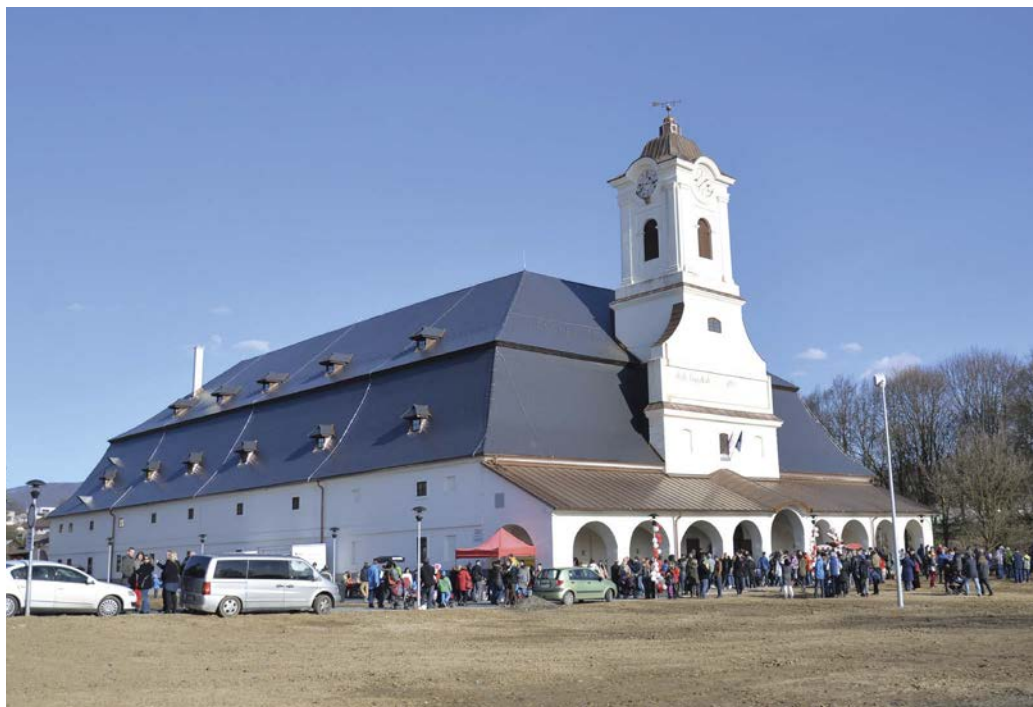
Zrekonštruovaný sklad soli. Foto Branislav Švorc
